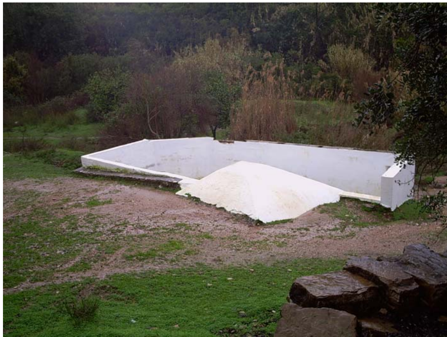
Edificación del manantial de Los Baños de la Hedionda (Jorge Jiménez Sánchez)
